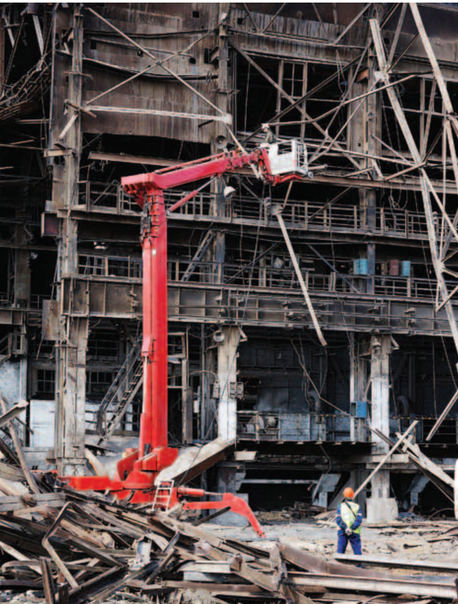
ПЕРЕД НАЧАЛОМ СТРОЙКИ НЕОБХОДИМО ДЕМОНТИРОВАТЬ БОЛЕЕ 300 ОБЪЕКТОВ СТАРОГО ПРОИЗВОДСТВА
